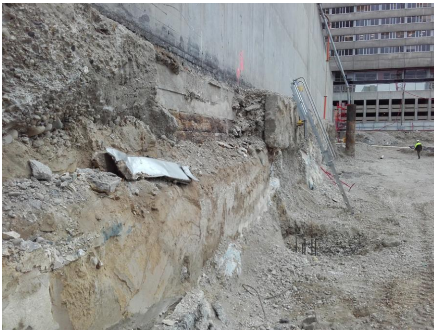
Figure 1. Photographie de la paroi au coulis lors du terrassement en 2017
