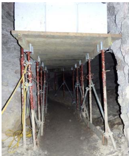
Figure 8 : soutènement provisoire
