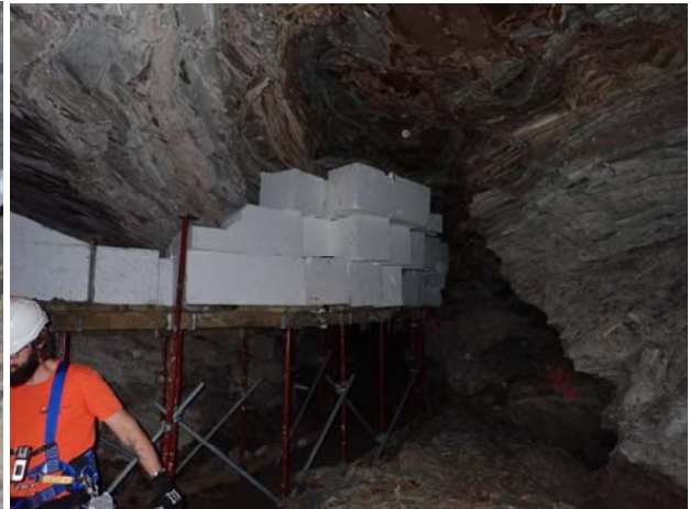
Figure 6. Chutes de toit
