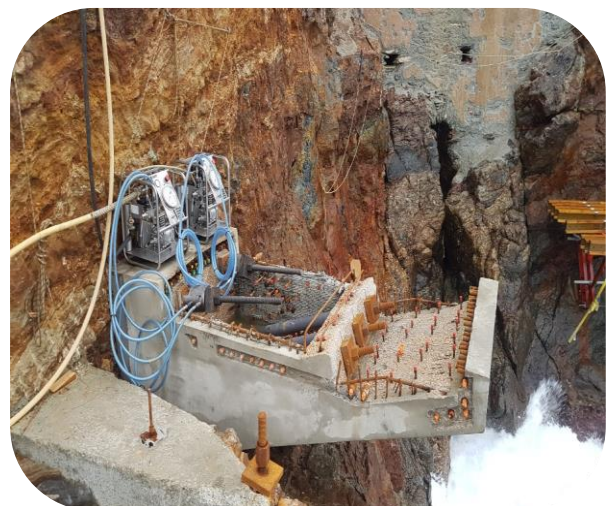
Figures 9 : à gauche forage des tirants - à droite mise en tension par vérinage
