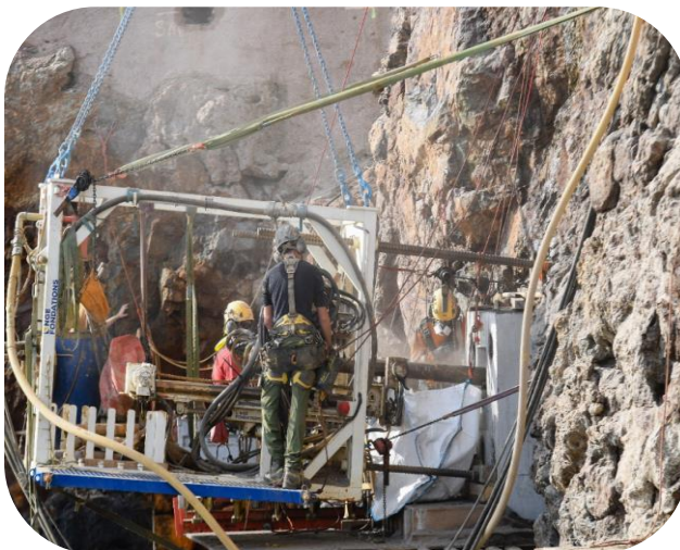
Figures 9 : à gauche forage des tirants - à droite mise en tension par vérinage
