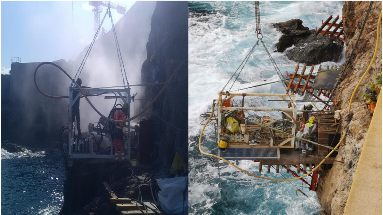
Figures 7 : Forage sur châssis suspendu et gabarit de guidage
