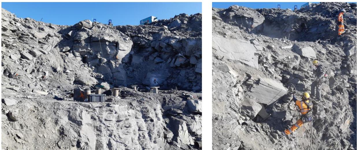
Figure 3 : Confortements aval des différents fronts d'excavation
