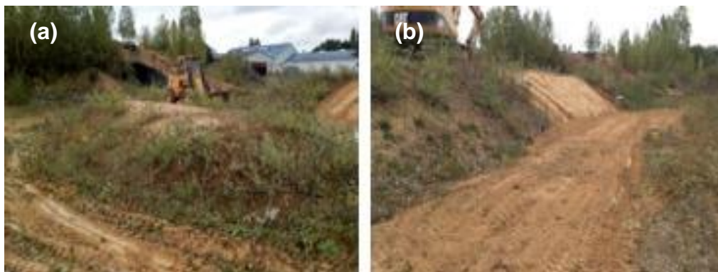
Figure 3. (a) Digue en sol limoneux non traité avant déconstruction et (b) talus 2/1 de la digue en sol limoneux traité à la chaux avant déconstruction (après décapage de la terre végétale sur partie centrale du talus).
