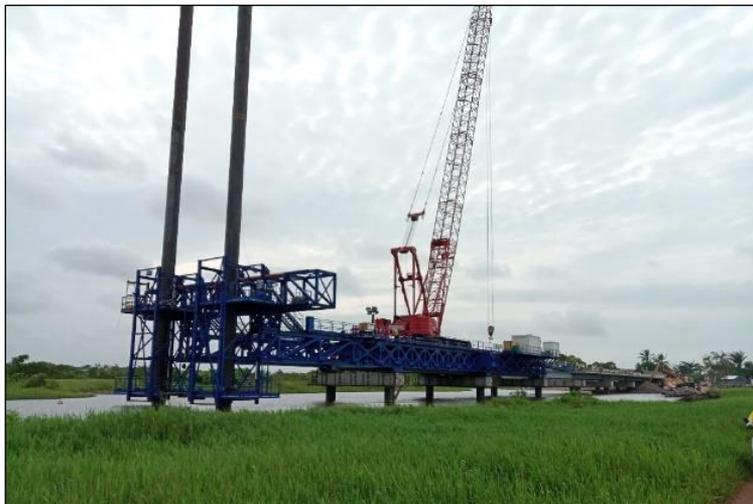
Figure 7. Vue du lanceur guide de battage depuis la piste traversant la lagune
