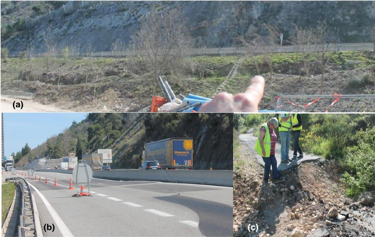
Figure 5. Arrachement visible sur le talus autoroutier (a), fissuration et tassement des voies circulées (b), rupture d'un chemin situé à l'aval (c)
