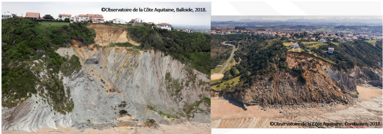
Fig 3. Mouvements de terrain récents affectant le secteur de la Falaise de la Corniche (Bidart)
