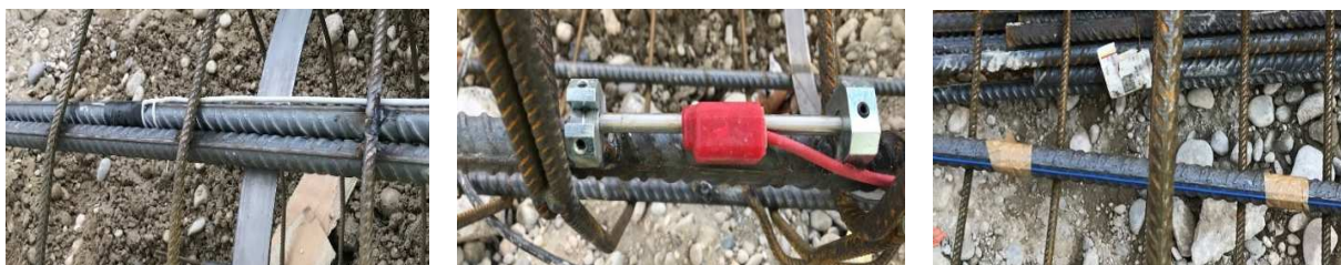
Figure 2. Photos prises sur chantier (à gauche, une jauge de déformation, au milieu, un extensomètre à corde vibrante et à droite, une fibre optique)
