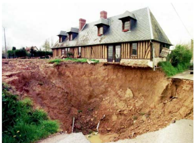
Figure 1. Configuration des marnières (DDT 76) – Effondrement à Neuville-sur-Authou en 2001
