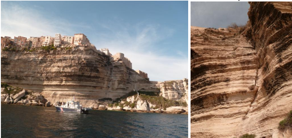
Figure 1 – Photos du secteur d'étude du pilier de la Citadelle et de la fracture N110°
