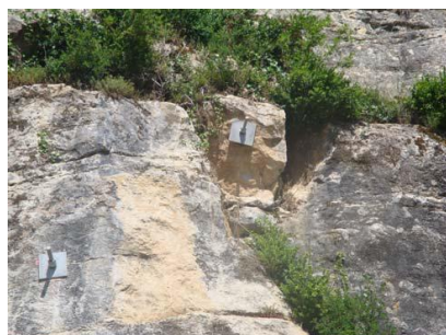
Figure 1. Ancrages passifs scellés au rocher utilisés pour la stabilisation d'une paroi rocheuse
