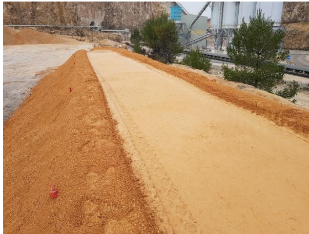
Figure 4. Massif constituant la planche d'essais
