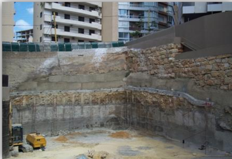
Figure 1 Soutènement par pieux espacés d'une excavation profonde à Beyrouth
