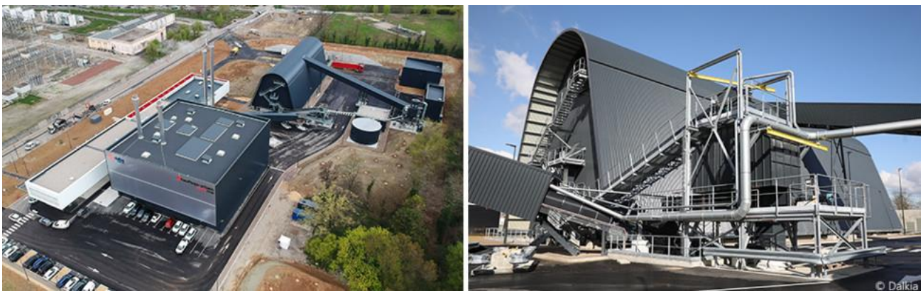
Figure 2. Inauguration de la centrale biomasse (Crédits : Dalkia).
